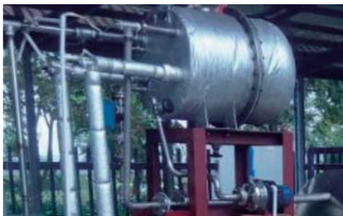
图2 蒸馏器主体装置图
